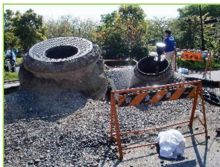
液状化で隆起・陥没した外山さんちの近くの公園＝4月25日
